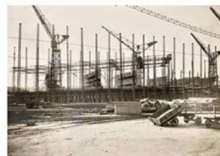
Asoyrie. Montage des membrures, 20 mars 1925.
