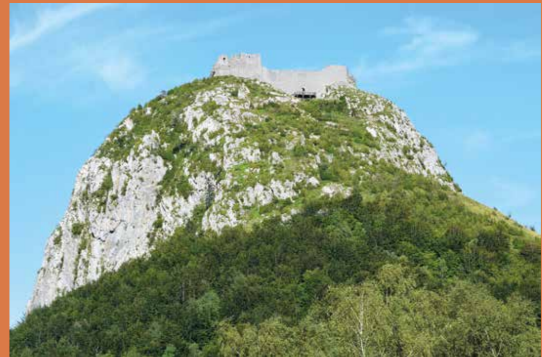
Vue du château de Montségur (Ariège).
