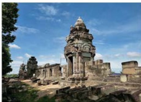
Fig. 1 Vue de l'est vers le temple du Mébon occidental au cours de restaurations, mai 2015.
